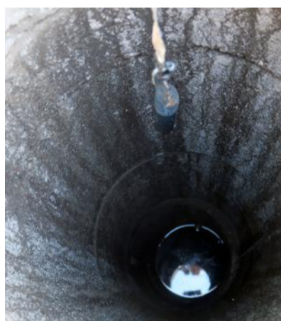
Des relevés réalisés chaque semaine permettent de mesurer le niveau de la nappe phréatique.
